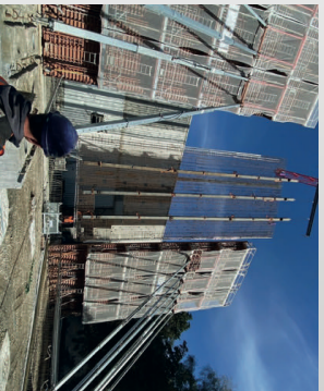
Voile grande hauteur (ht = 18,00m) Dimensions treillis : 9,00 m x 2,80 m Maille Ø14xØ14
