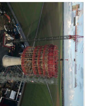
Voile coffrage girnant Dimensions treillis : 9,00 m x 2,95 m (cintres) Maille Ø14xØ10
